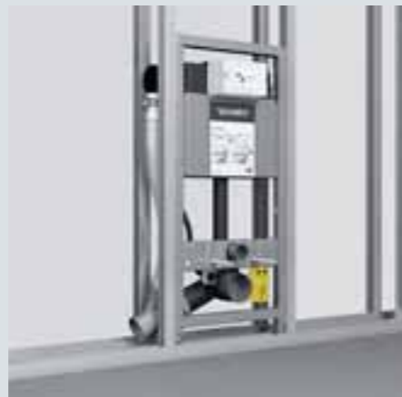
Trockenbau in Ständerleichtbauweise
