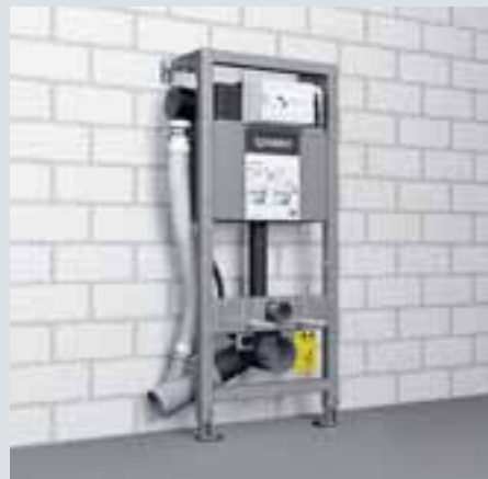
Trockenbau vor Massivwand
